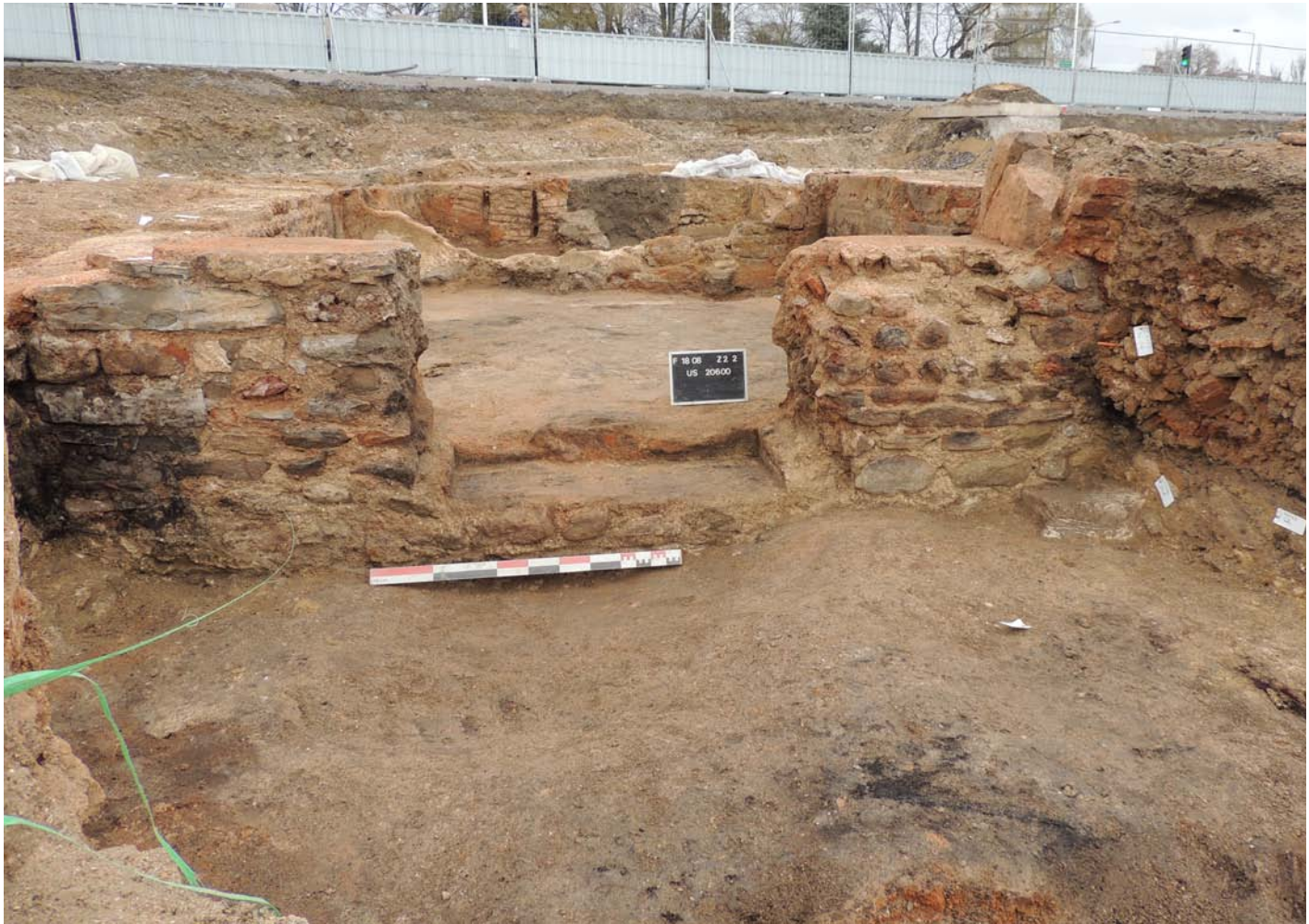
Figure 2 – Traces laissées par l'incendie révélant une conservation remarquable du bâti antique (cliché : SAGR).
