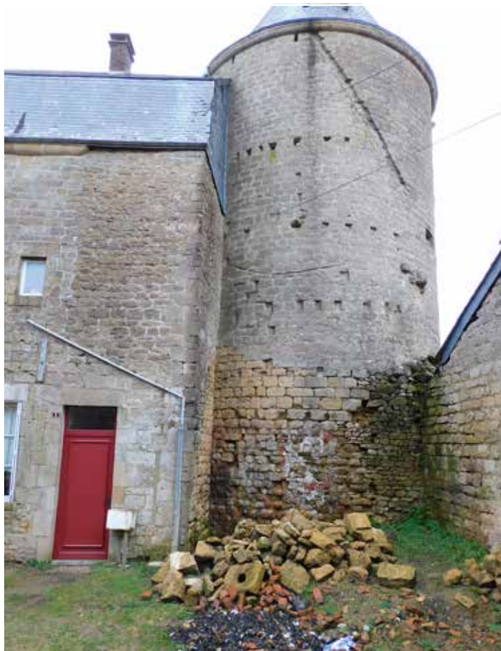
Figure 2 – Vue de la tour sud-est depuis l'ouest (© CD08).
