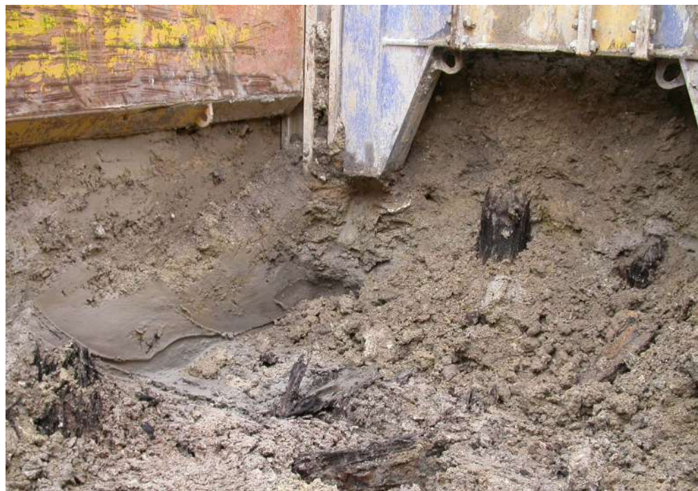
Figure 3 – Sous les blindages apparaissent de nombreux éléments en bois, difficiles à extraire puisqu'on arrive à la cote de profondeur. Leur lien avec les niveaux et structures fouillées est impossible à déterminer dans ces conditions. Troyes « rue Pierre Labonde » (© A. Rémy, Inrap).
